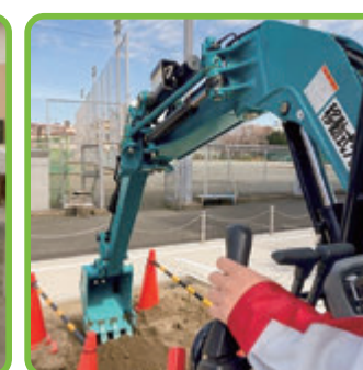
パワーショベルの操作
